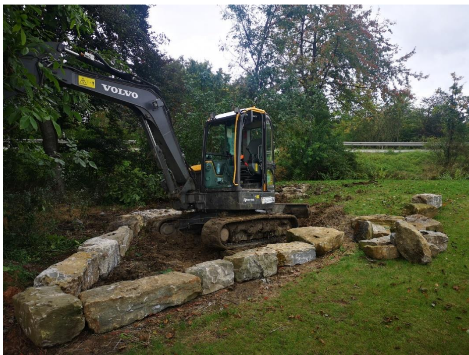
Fortsetzung und Abschluß der Rohbauarbeiten am 08.10.2021
