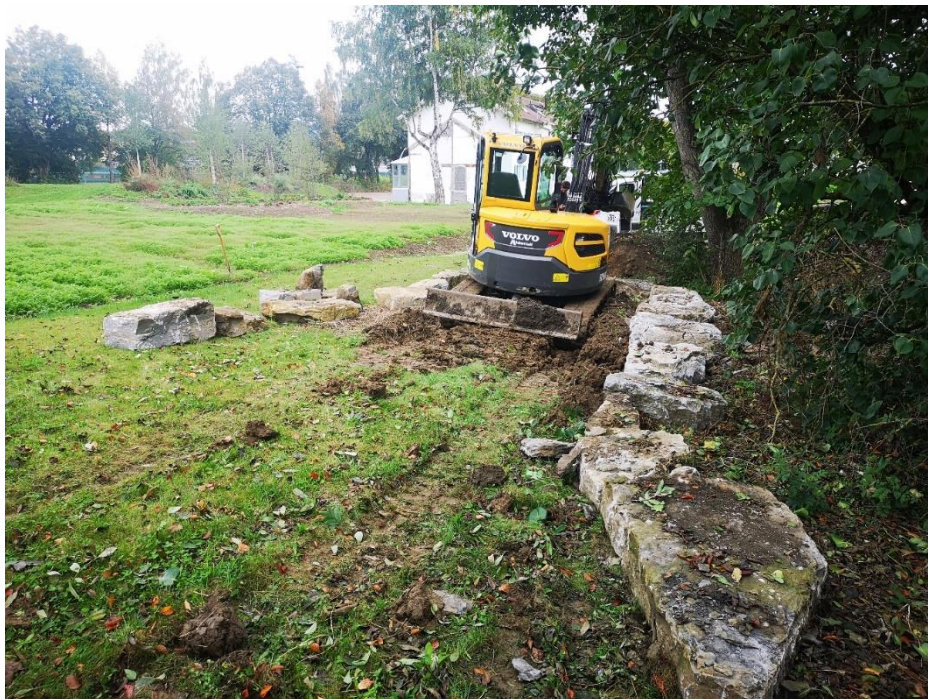
Beginn der Baggerarbeiten am 7.10.2021 durch die Mitarbeiter des Balingen Bauhofs
