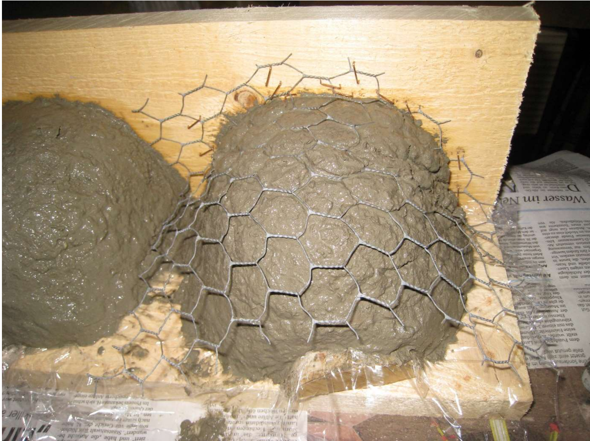
Ein Doppelnest im Bau: nach der ersten Schicht Gipsbrei wird ein Drahtgeflecht aufgelegt, festgetackert (nur an hinteren Brett, das nachher nicht mehr abgezogen wird) und eine zweite Schicht aufgetragen.
